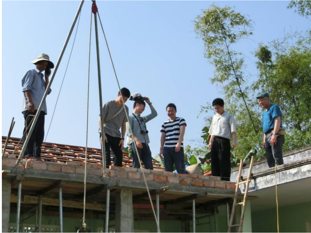
民家の屋根の修繕作業
