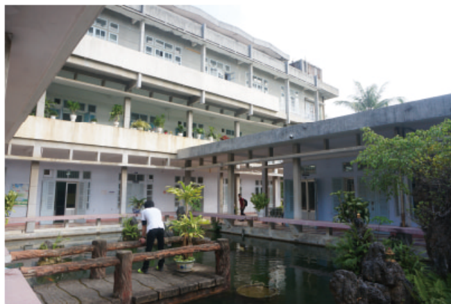
建物内の池 建物の廊下などは外に面している
